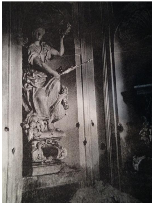
Rys. 17. Fragment wnętrza pałacu Łazienkowskiego z wykonanymi otworami na ładunki wybuchowe [16].
