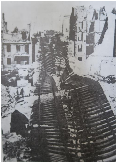
Rys. 18. Zniszczony wiadukt kolejowej linii średnicowej[18].
